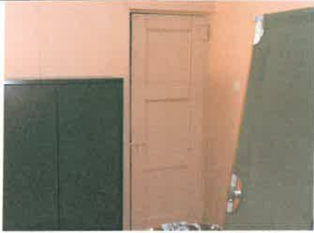
Rd. 104, Room 11, Door Frame 84" x 28"
