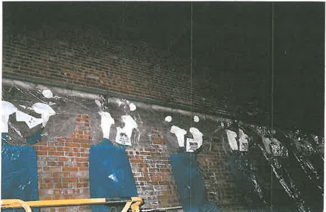
Glovebag asbestos abatement of piping
