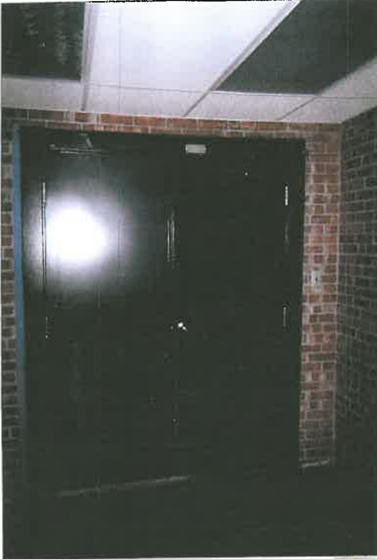
New double door unit
