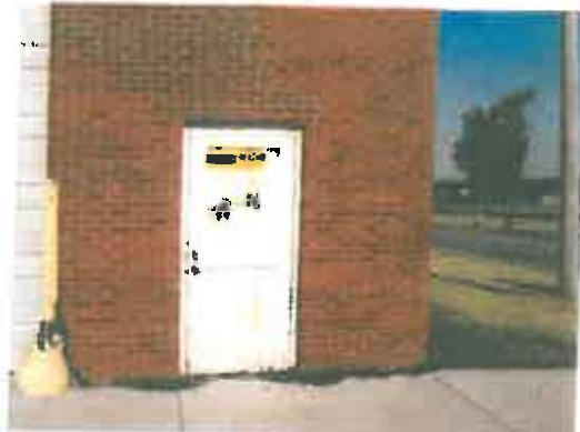
Photo # 4: Beige door, door frame, and lintel - LBP.
