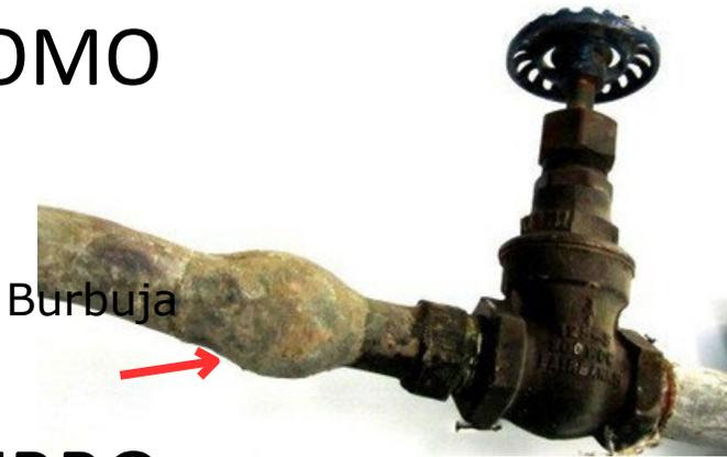
Un tubo de color plateado opaco que se puede rayar fácilmente con una moneda o con una llave. Al rayarse queda un color plateado brillante. Los imanes NO se pegan en los tubos de plomo. Los tubos de plomo se pueden doblar y comúnmente tienen una "burbuja".
